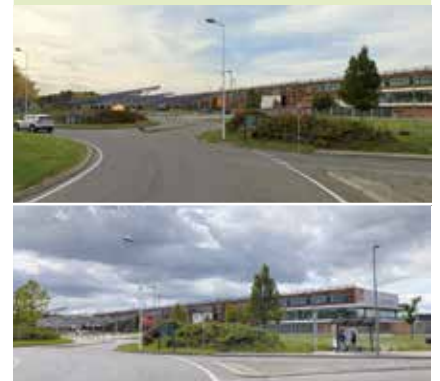
Ombrières prévues sur le parking devant le lycée Clémence-Royer. Une partie du projet retenu avec la société Trina Solar en cours d'instruction.
