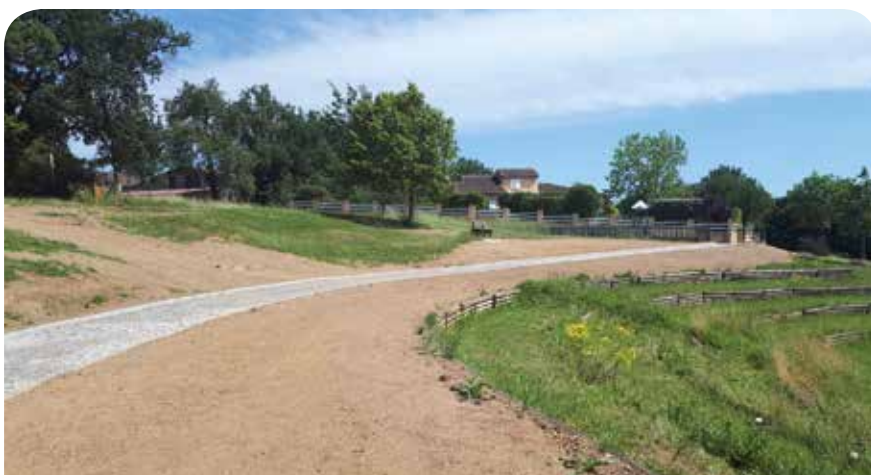
Nouveau cheminement piétonnier au parc des Lavoirs.
