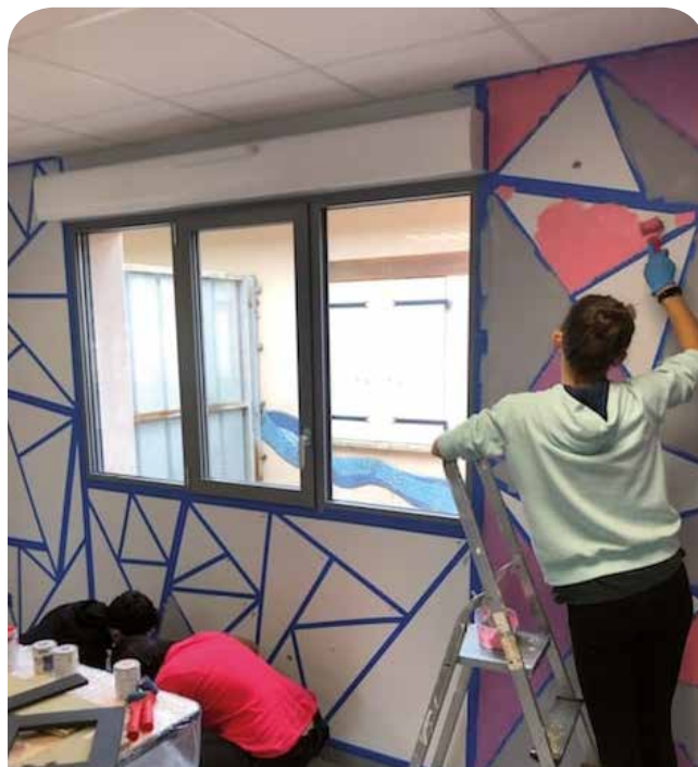
Peinture des murs de la salle.
