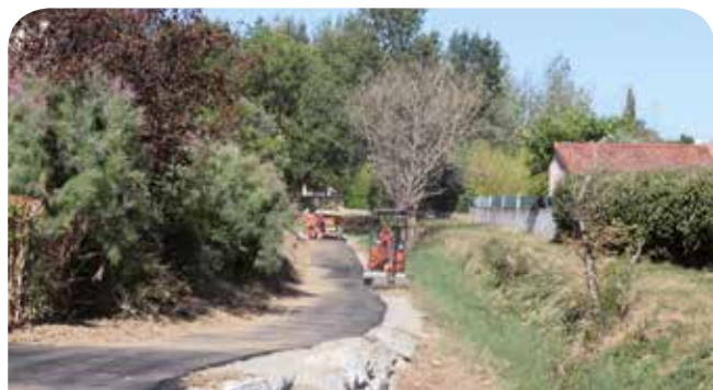
Réalisation du cheminement piétonnier du Riouvet entre l'école de la Béouzo et le rond-point du Banayre.
