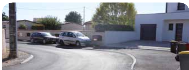
Aménagement du virage chemin Calléou.
