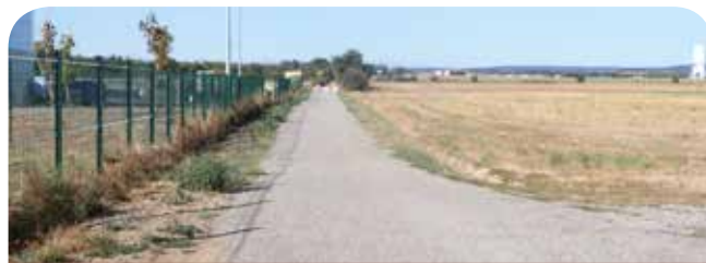
Réalisation du piétonnier chemin des Moudinats.
