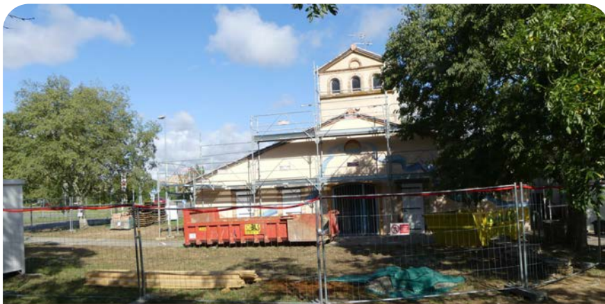
Les travaux en cours.
