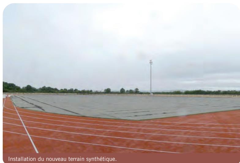
Installation du nouveau terrain synthétique.
