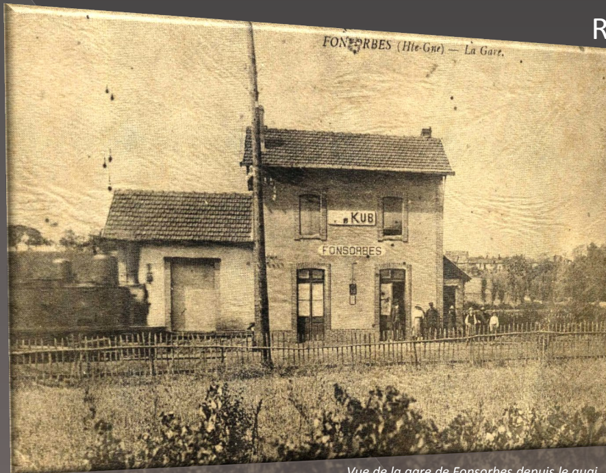
Vue de la gare de Fonsorbes depuis le quai Carte postale du début du XX e siècle
