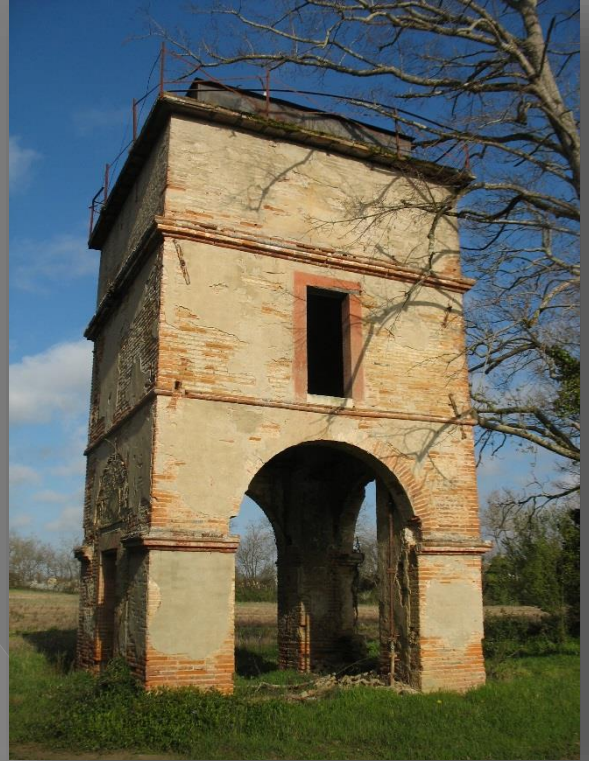
Le pigeonnier à arcades avant sa restauration
